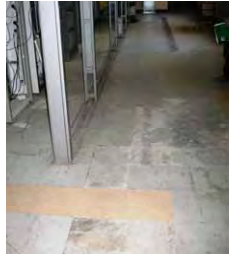
Dalles dégradées à Béziers Riquet :
